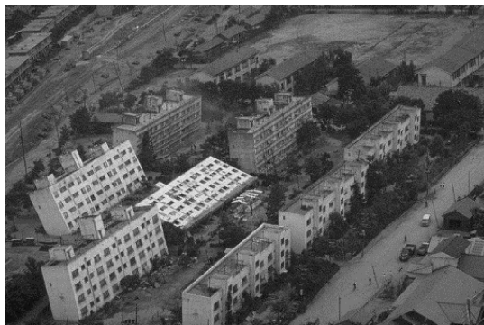
Рис. 5.4. Опрокидывание зданий в Ниигате при сейсмических нагрузках из-за деформаций грунта
